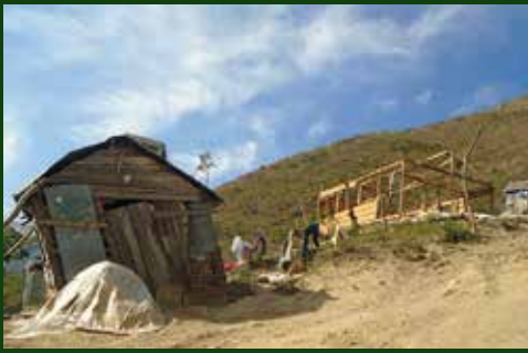
Aangezien het oude huis in te slechte staat is voor een nieuwe cementen vloer, wordt er een nieuw huis gebouwd.
